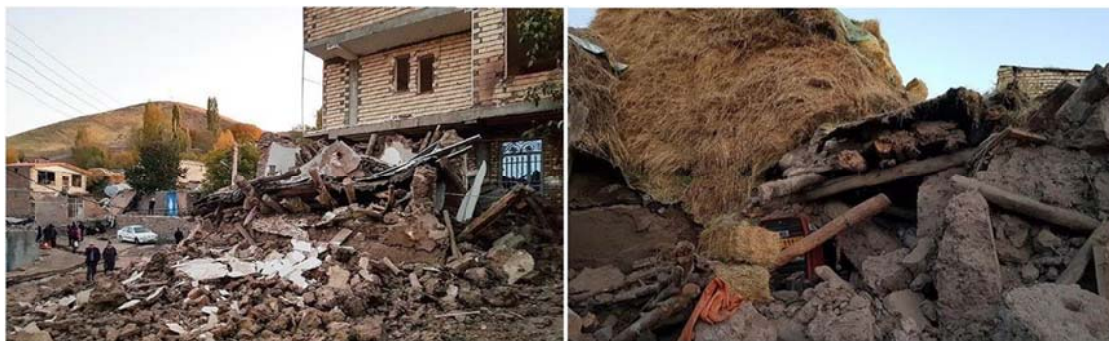
شکل ۶. تصاویری از تخریب نواحی مسکونی روستای ورنکش میانه.
